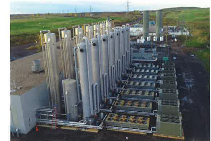
Usine de production de gaz naturel vert, Terrebonne, Québec
