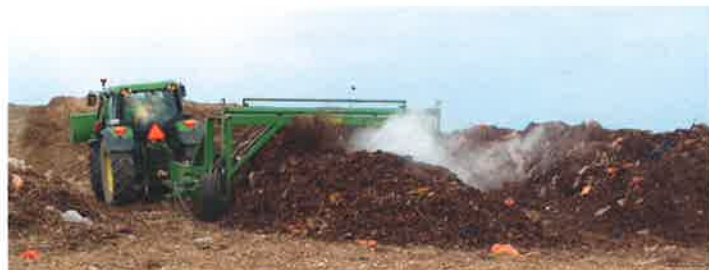
Plate-forme de compostage, Terrebonne, Québec
